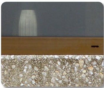
Streepvorming door een te agressief ramenwas product
