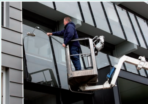
Werken vanaf een mobiel arbeidsmiddel
