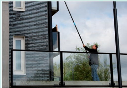
Werken vanaf een plat dak
